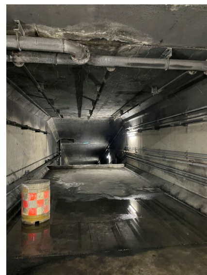
④東換気ダクト内から真鶴トンネル方向を撮影
