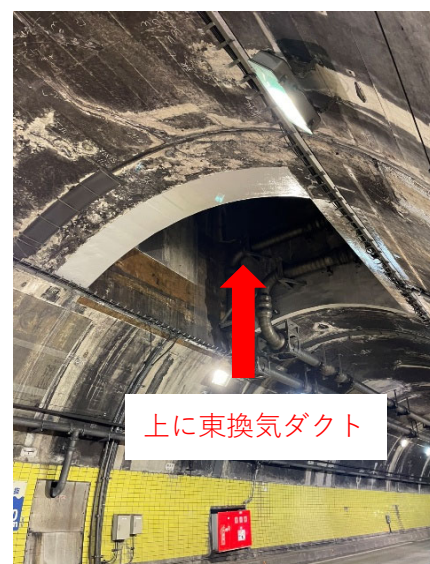
①真鶴トンネル内から東換気ダクト方向を撮影
